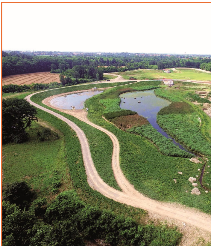
Figura 4. L'area di fitodepurazione ed il laghetto (sulla sinistra) nelle vasche di laminazione (foto: Parco del Lura).
