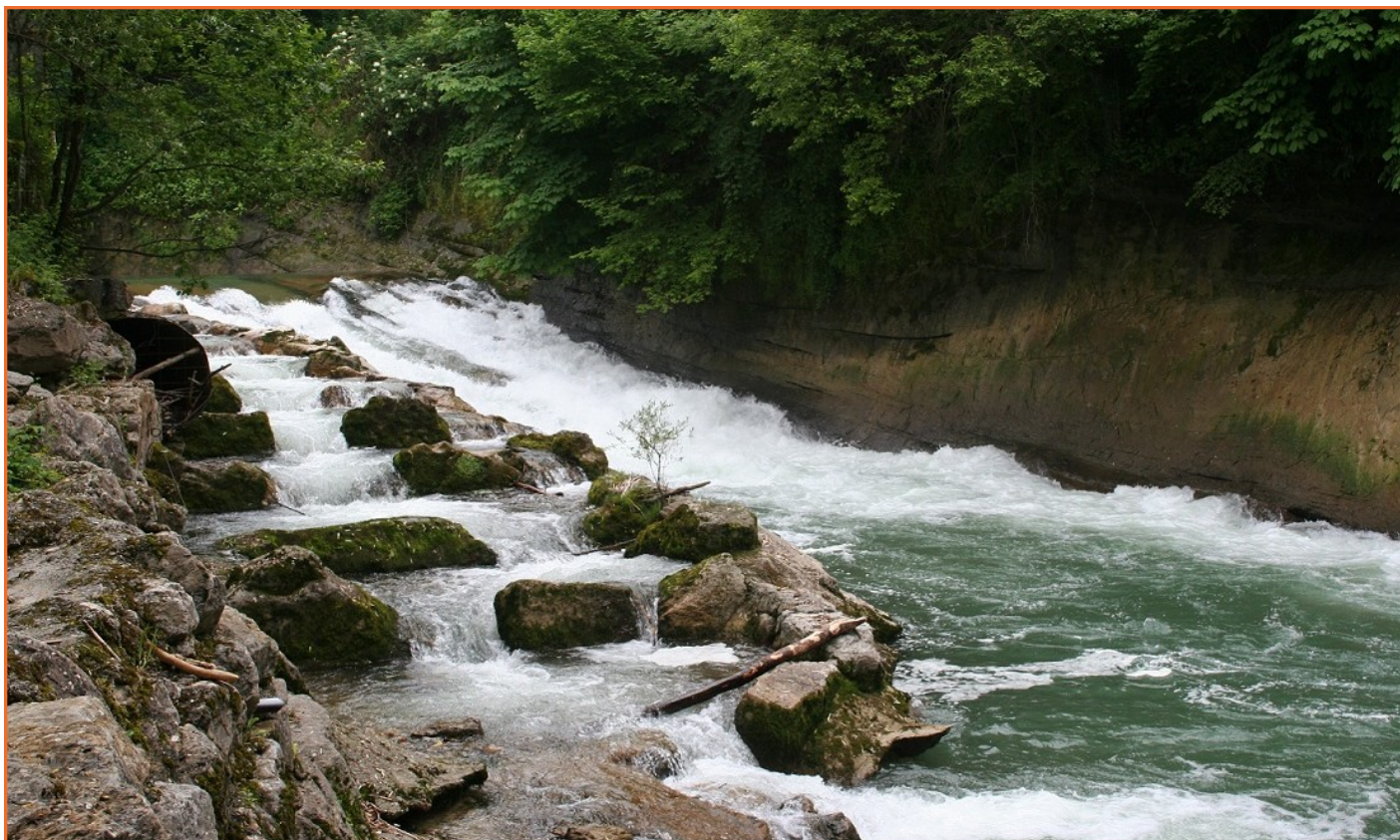
Figura 3. Scala di risalita per la fauna ittica (foto: Regione Piemonte).
