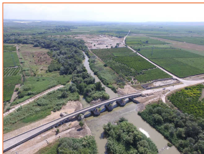
Figura 5. Il Ponte Romano sul Fiume Ofanto verso sud-ovest (estate 2019) (foto di M. Jacoviello).
