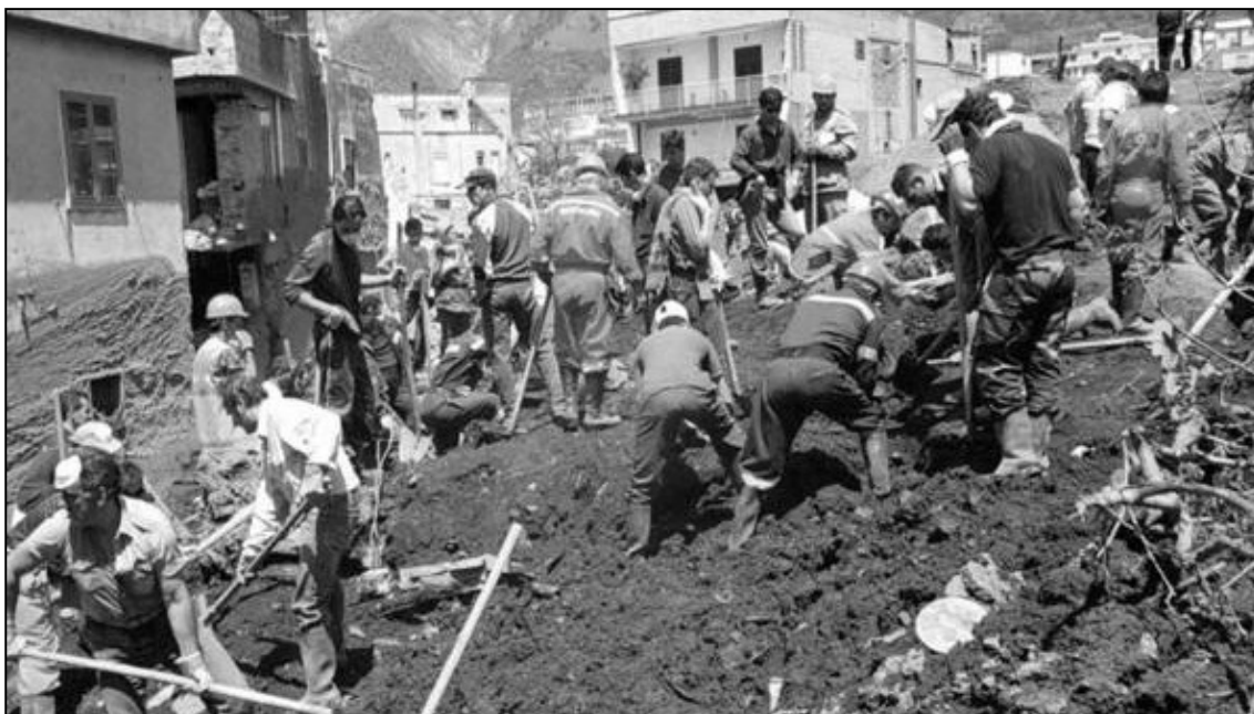
Figura 2.3 Particolare dei soccorsi sull'area interessata dalle colate di fango del 5 maggio del 1998 a Sarno e Quindici, dove persero la vita 160 persone;
