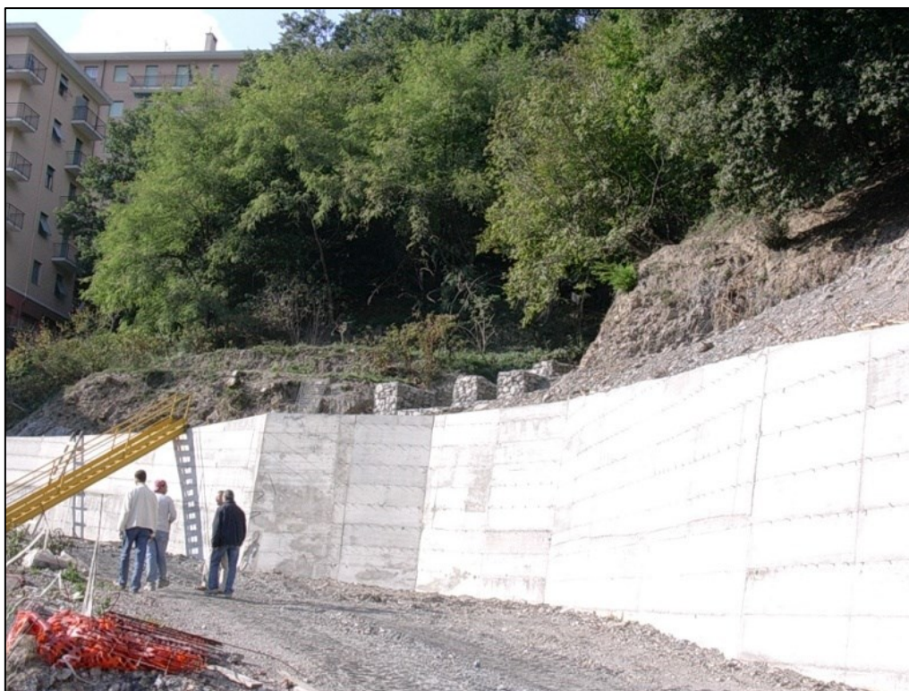
Figura D.7 Muri di sostegno in località Salita Brasile Bolzaneto (intervento cod. ReNDiS 488/02)
