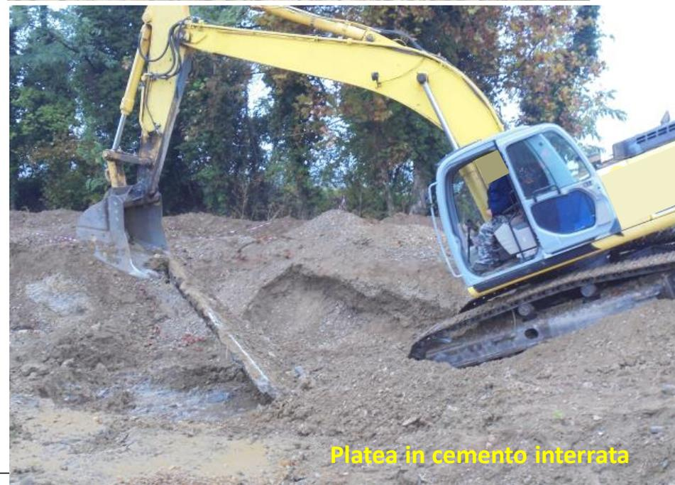
Possibile Causa: 1)Rifiuti: inadeguato smantellamento del cantiere, inadeguata pulizia del piano campagna, scorretta gestione delle dune di vegetale; 2)Superamento CSC: sversamento o contatto con depositi contaminati
