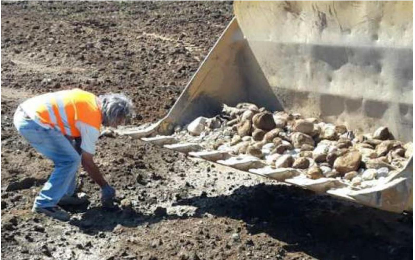
Lavorazioni eseguite da personale non specializzato in ripristini pedologici e tramite attrezzature inadeguate
