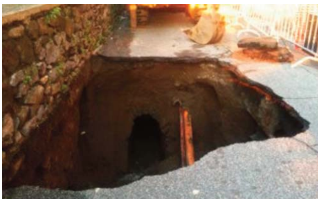
Fig. 13 - Voragine in Via del Fossato Novembre 2014 e galleria individuata. - Sinkhole in Via del Fossato November street 2014, and tunnel identified.
