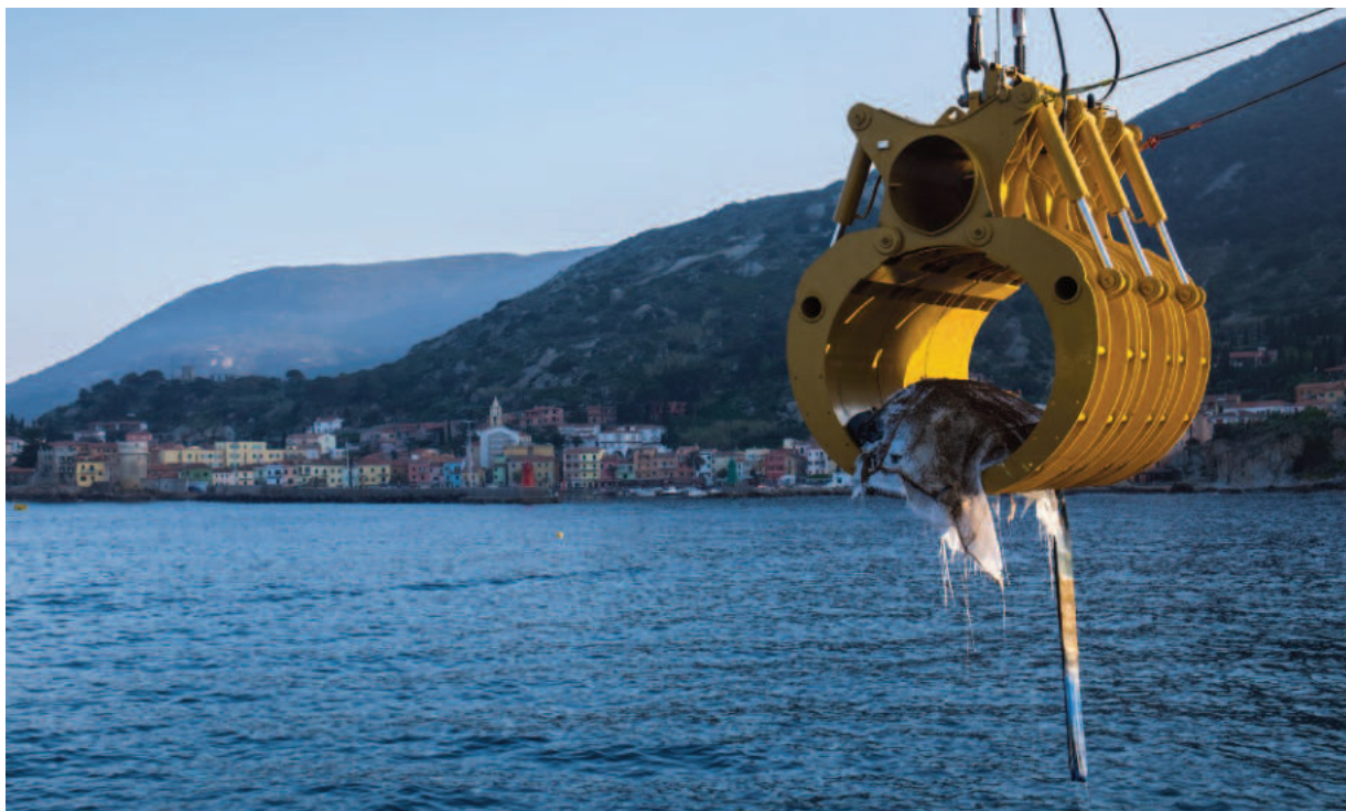
Figura 8.4: Rimozione dei grout bag con una benna appositamente realizzata.
