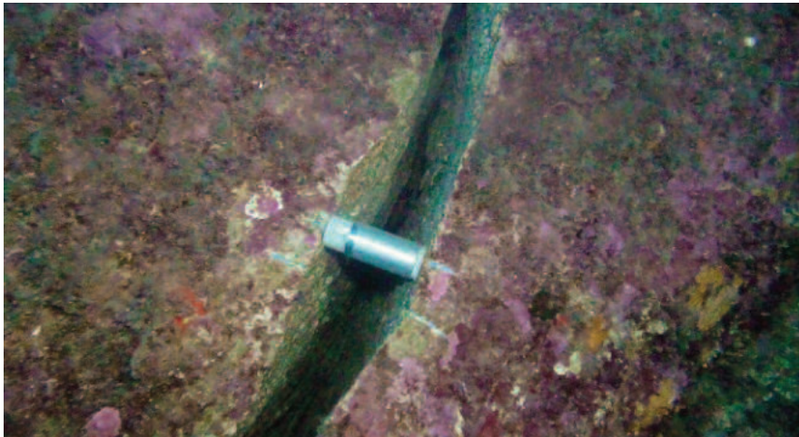
Figura 5.11: Fratturazione del granito in uno dei punti di contatto con lo scafo (fermo immagine da video con ROV ISPRA).
