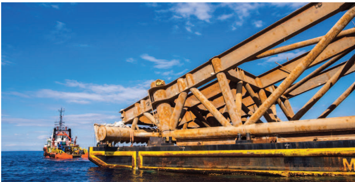
Figura 8.7: Una delle sei piattaforme posizionate su un pontone per il loro trasferimento a terra dove il metallo è stato recuperato.
