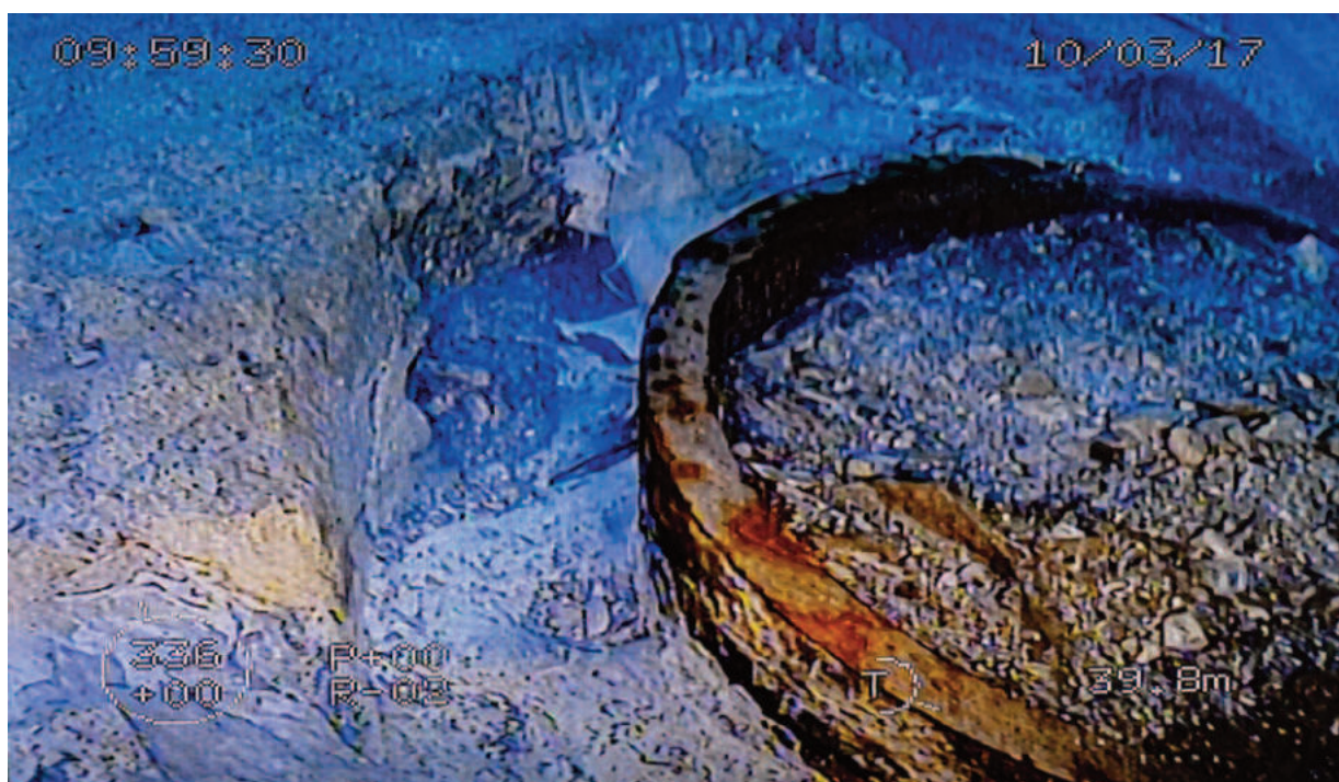
Figura 8.8: Alcuni dei residui di pali delle piattaforme rimasti sul fondale.
