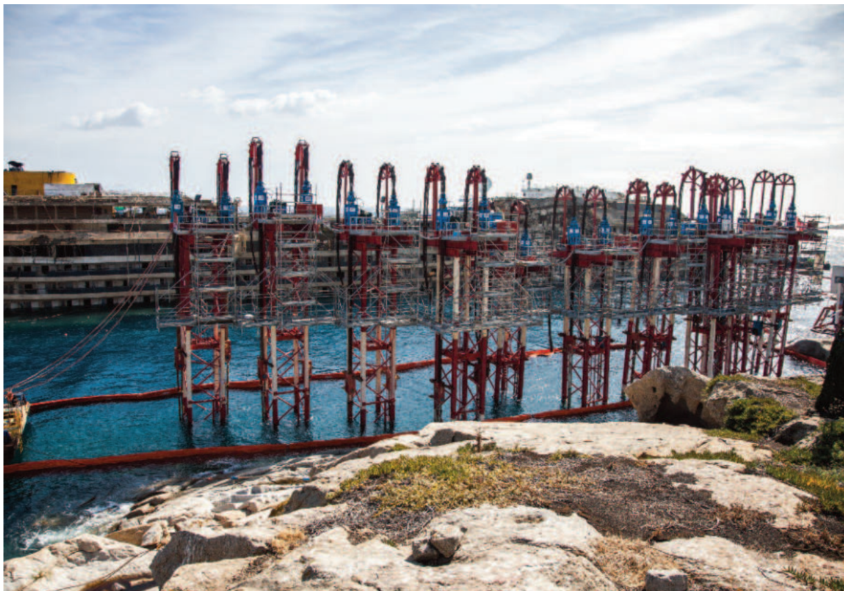
Figura 6.3: Le 11 torrette sopra gli anchor block utilizzati per trattenere il relitto. In cima si notano gli strand jack che tendevano i cavi di collegamento con lo scafo.
