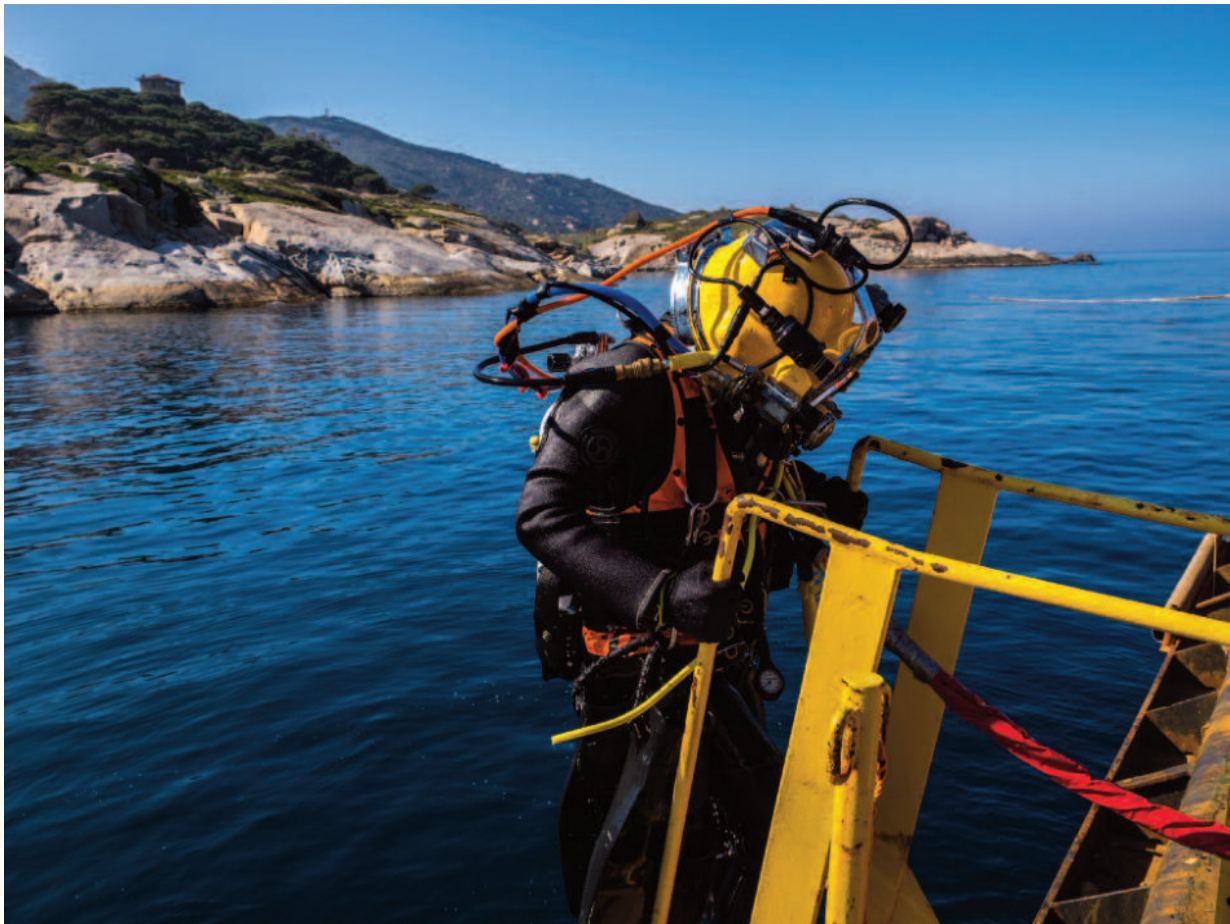
Figura 8.12: Operatori subacquei altofondalisti si immergono per eseguire le operazioni di sorbonatura.
