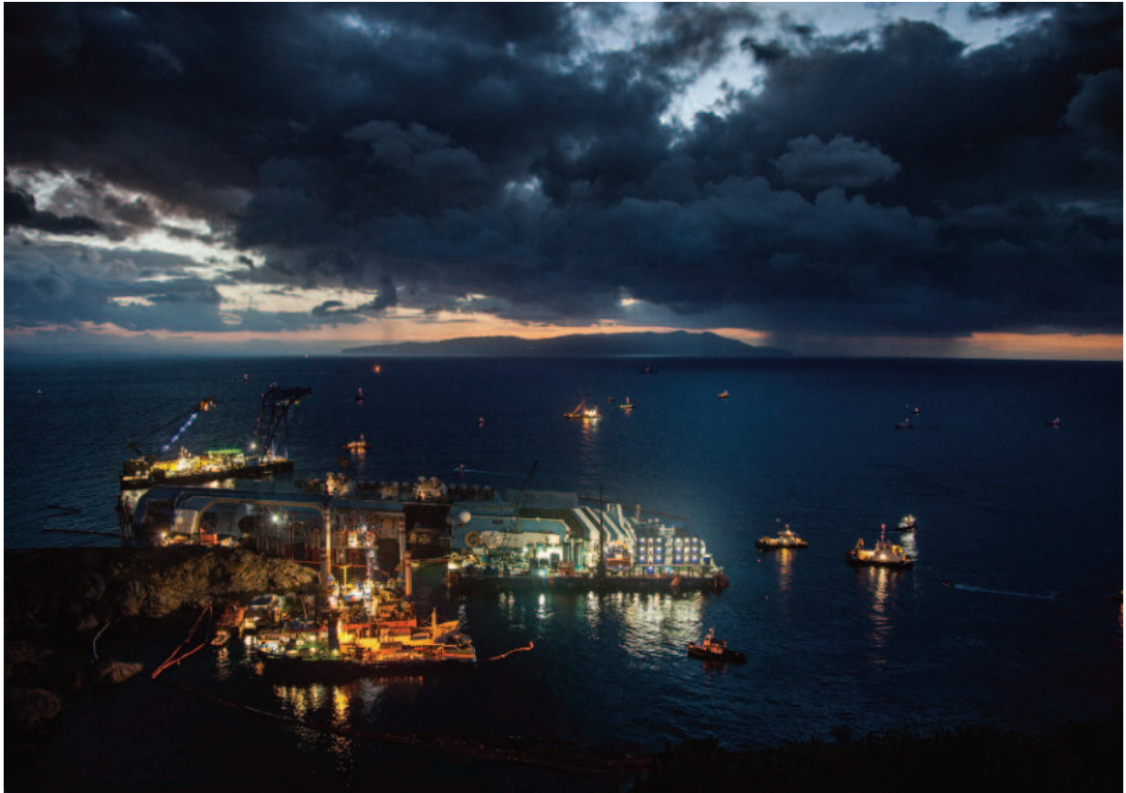
Figura 6.10: Alba del 16 settembre 2013, tutto è pronto per iniziare l'operazione di rotazione.
