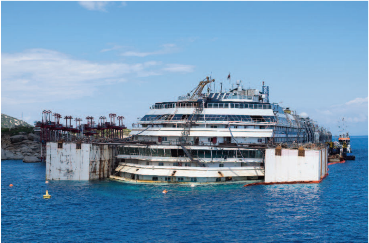
Figura 6.16: Luglio 2014, iniziano le operazioni di rigalleggiamento del relitto.
