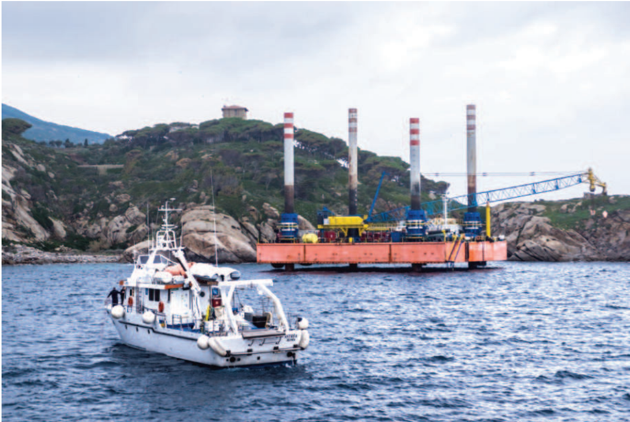
Figura 10.1: La N/O Astrea durante una fase del monitoraggio nell'area di cantiere.
