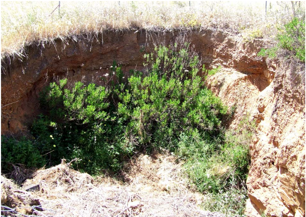
Figura 17b: Immagine di dettaglio dei sinkhole mostrati nella figura 17..
