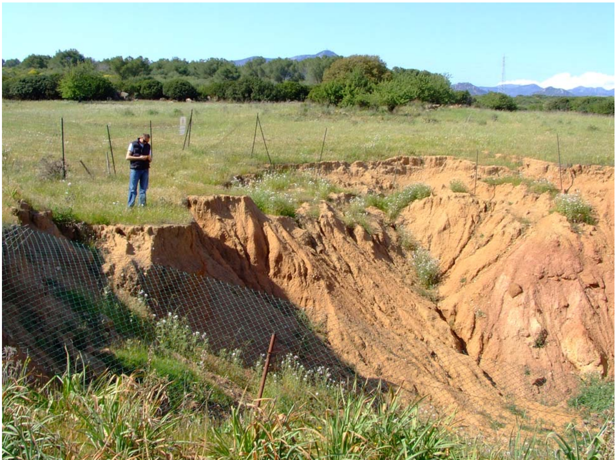
Figura 27b: Sinkhole in Località di Caput d'Acquis (Monti Ollastu, foto 2008).
