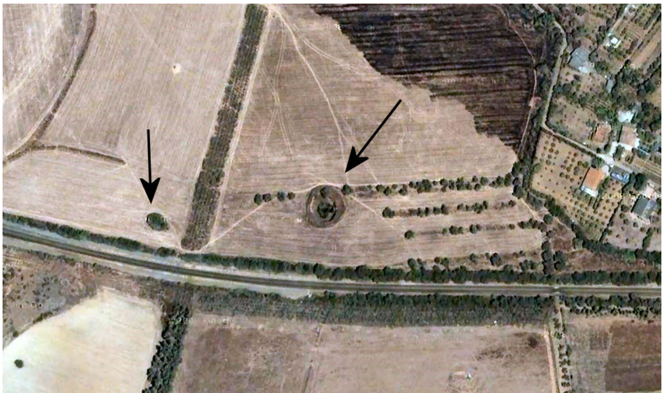
Figura 16: Veduta aerea dei sinkholes presenti nel settore interessato.
