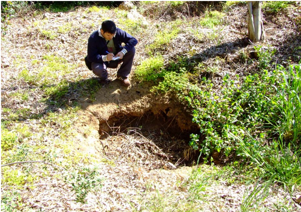
Figura 7: Sinkhole nel Comune di Nuxis ( Sardegna Sud-Occidentale).
