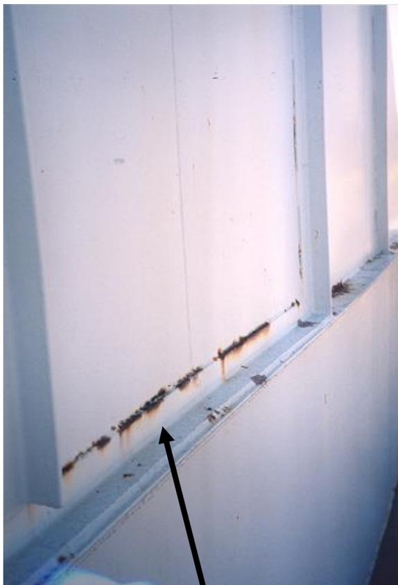
**Corrosione tra lamiera scudo e telaio**
