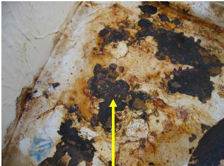
**Distacchi diffusi con corrosione**
