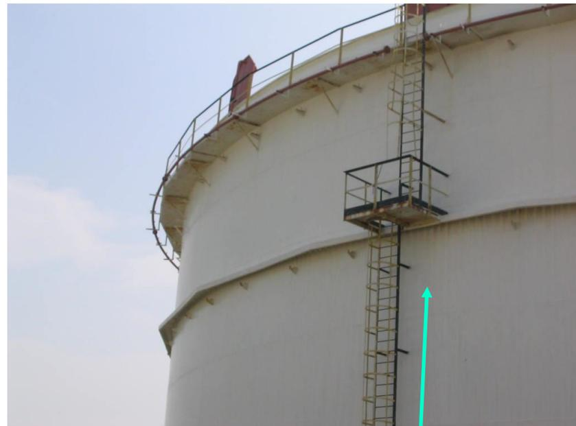
**Scala di vecchio tipo supporti direttamente saldati al mantello**
