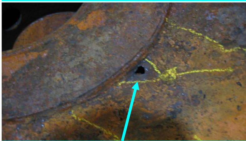
**Corrosione passante vicino pozzetto**
