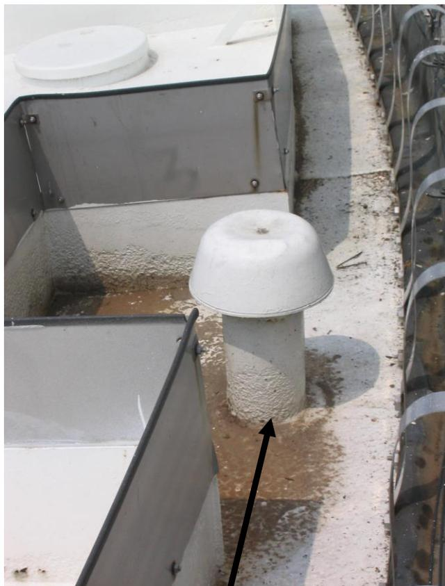
**Corrosione alla base colpetto bocchello**
