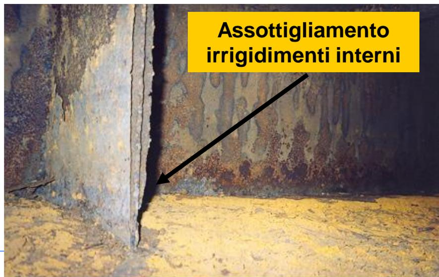
Perforazioni per corrosione
