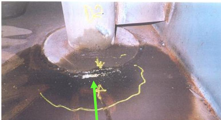
Trafilamento da saldatura penetrazione
