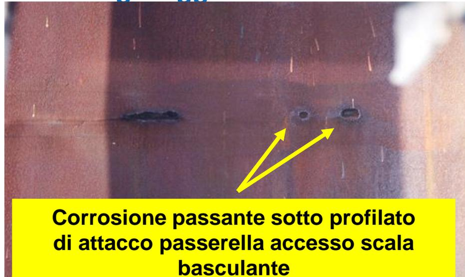
**Corrosione passante sotto profilato
