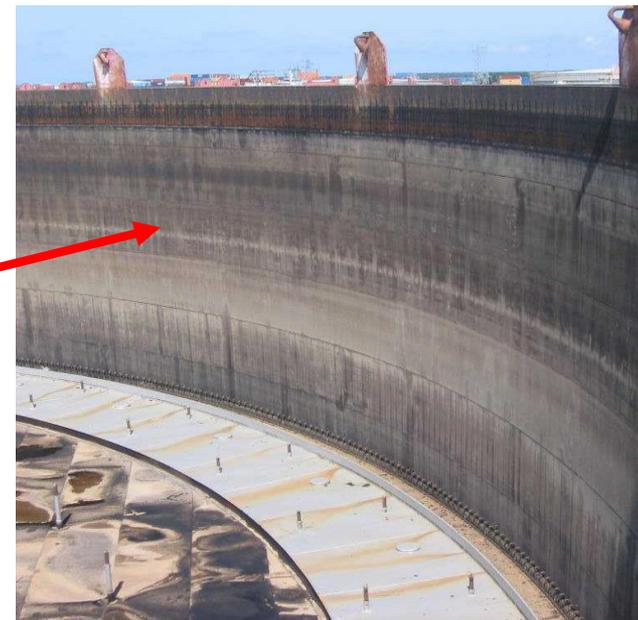
Verniciatura con sintomi di invecchiamento
