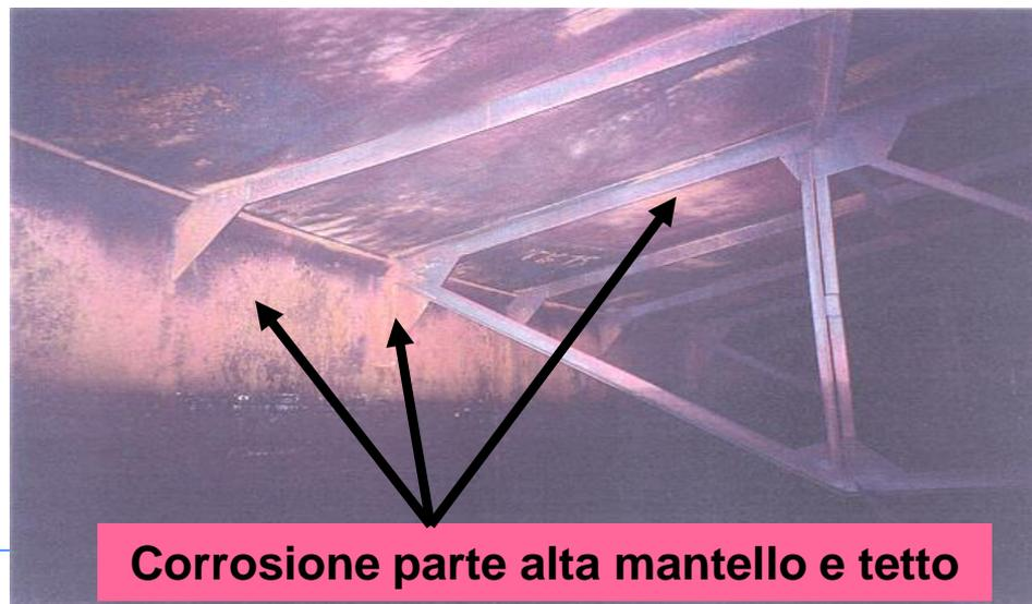
**Corrosione parte alta mantello e tetto**
