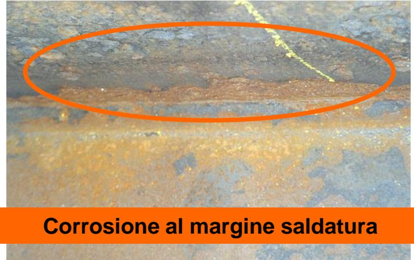
**Corrosione al margine saldatura**
