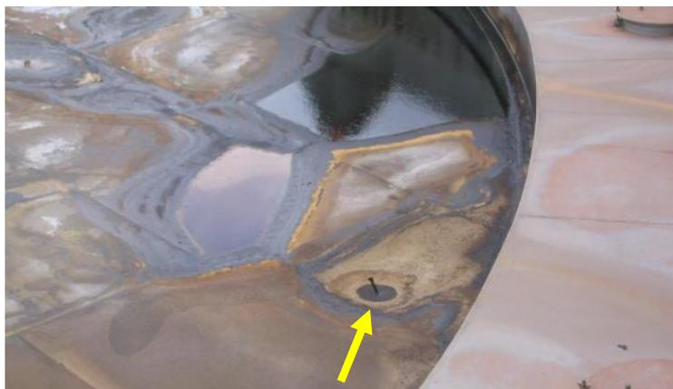
**Tamponamento temporaneo di un trafilemento**
