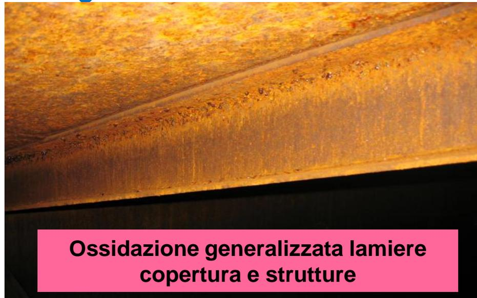
**Ossidazione generalizzata lamiere copertura e strutture**
