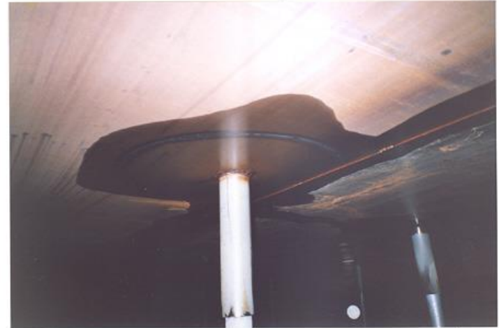
TETTO (SOTTO IL TETO CENTRALE): PARTICOLARI SALDATI SOTTO POSTI ALLA PROVA CON GASOLIO LEGGERO.
