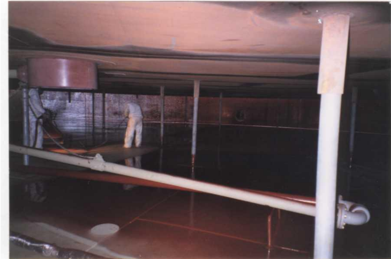
Pittura di un fondo serbatoio con metodo AIRLESS
