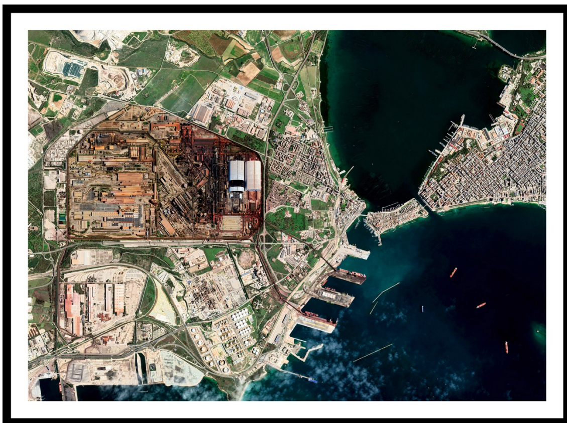
FIGURA 1 – SUL LATO SINISTRO SI OSSERVA L'IMPIANTO SIDERURGICO CON LA SUA ESTENSIONE DI 15 KM 2 .
