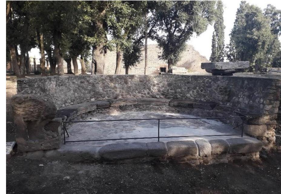
**Foro Triangolare – Schola:** messa in sicurezza strutture murarie, integrazione pavimentazione, ricollocazione soglia, progettazione e messa in opera barriera
