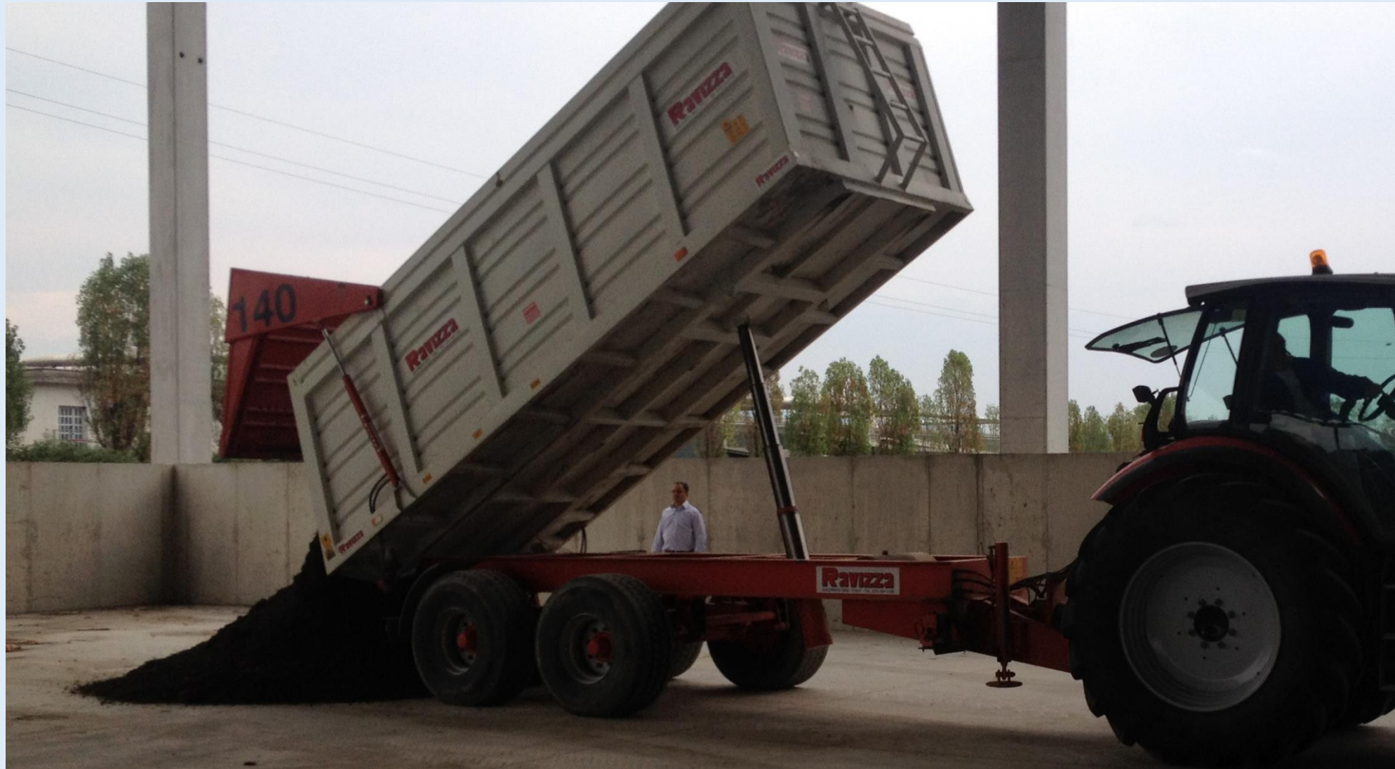
Risanamento biologico attuate mediante la tecnologie delle biopile dinamiche Lavorazione del sottovaglio – formazione delle andane
