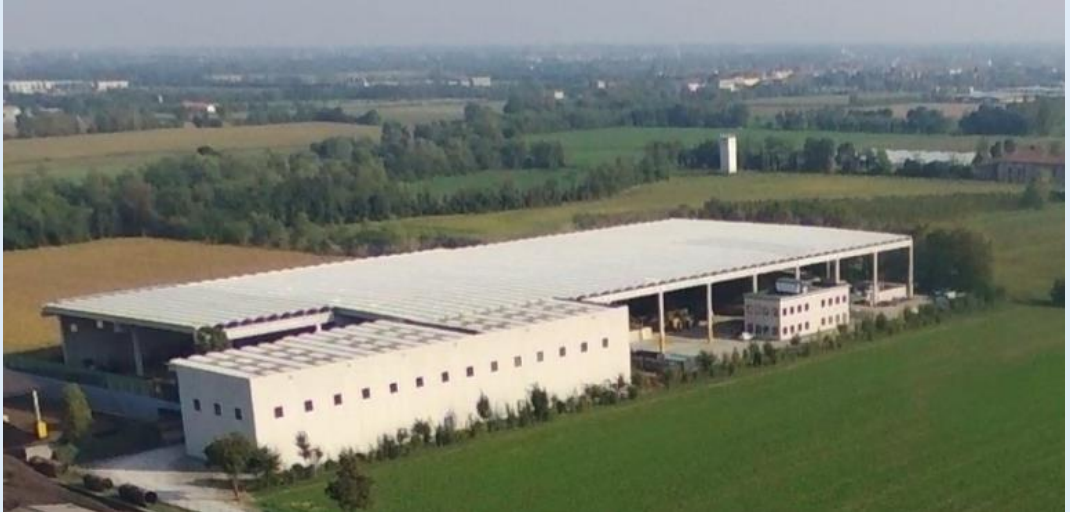
Veduta aerea dell'impianto
