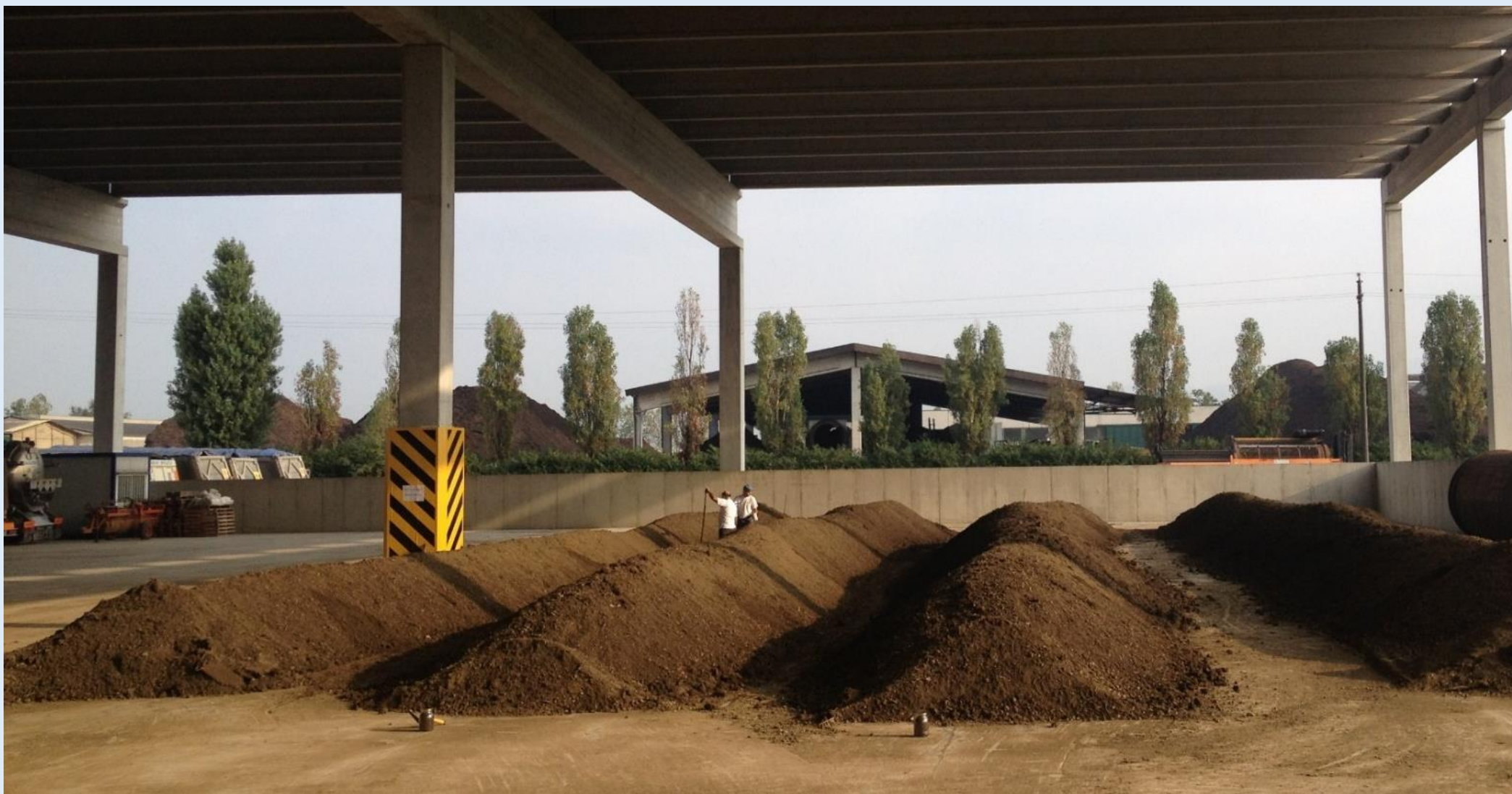
Risanamento biologico attuate mediante la tecnologie delle biopile dinamiche Lavorazione del sottovaglio – andane pronte per il rivoltamento
