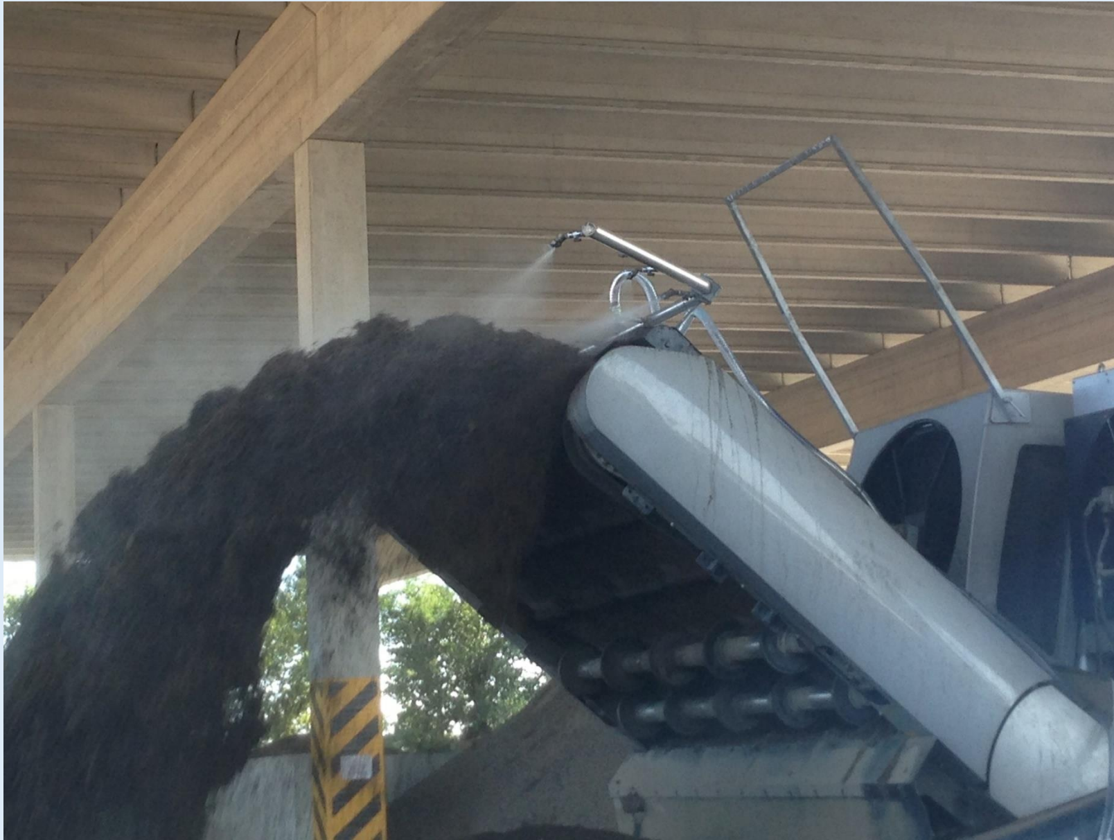
Abbattimento polveri mediante nebulizzazione ad acqua
