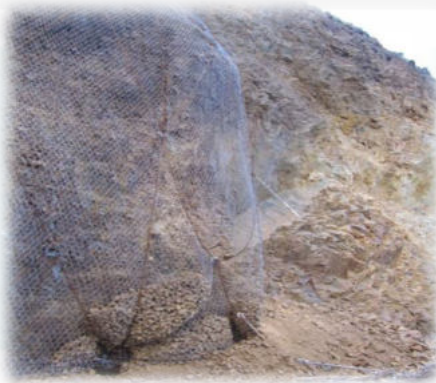
Dettaglio delle reti in aderenza poste presso impocco del tunnel Romano
