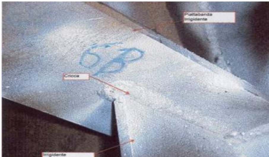
Cricca di fatica in struttura di carpenteria (ponte)
