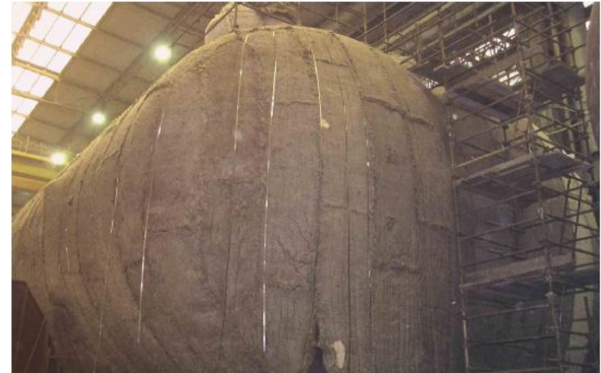
SERBATOIO COIBENTATO QUASI COMPLETAMENTE
