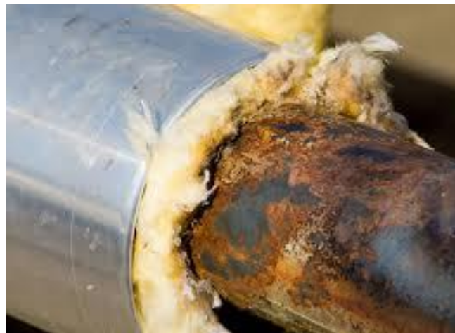
Un esempio di corrosione sotto coibente di una tubazione
