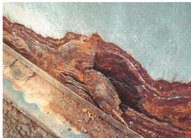
Un esempio di corrosione sotto coibente alla base di un serbatoio
