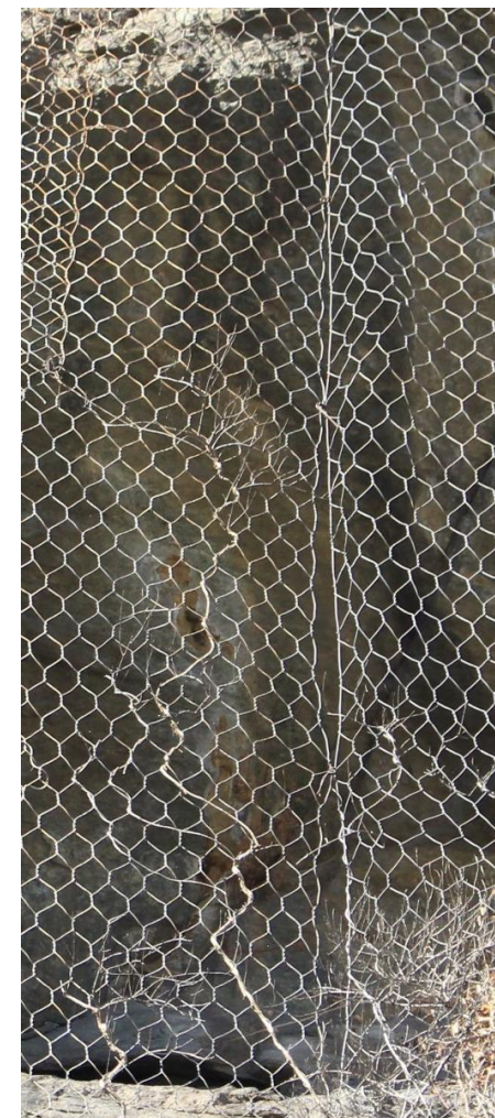
Elementi di giunzione mancanti
