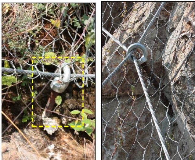
Scalzamento delle fondazioni/ancoraggi
