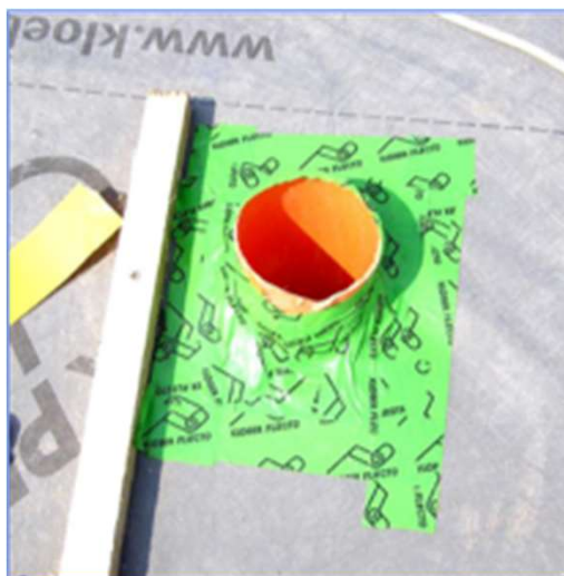
Esempio di sigillatura di tubazioni
