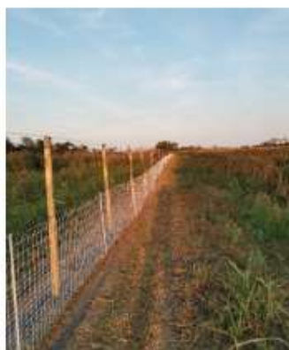
Fig.35. Particolare della paleria che sorregge la recinzione elettrificata (foto di D. Tramontana)
