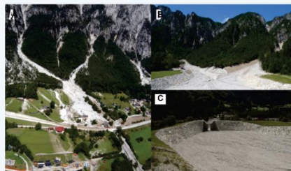
Fig. 6.18 – A) Panoramica da elicottero della frana (Foto: Protezione Civile FVG, 2003); B) Opere di protezione spondali; C) Vasca di ritenuta.
