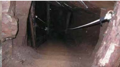
Fig.2: Rimonta attrezzata per il collegamento tra livelli.
