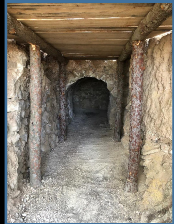
Strutture fusorie dai calcaroni ai forni Gill
