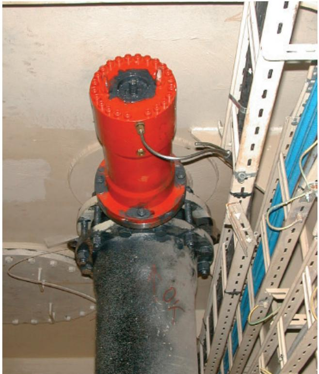
Sistema di trattamento delle acque di zavorra, valvola (A. Petri)
