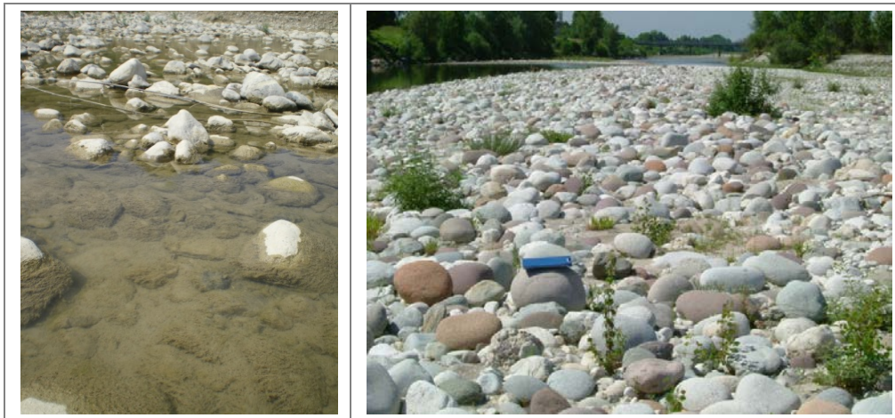
Figura 12.8 – Esempi di notevoli alterazioni del substrato attribuibili a forti alterazioni idrologiche ( caso 6 ): clogging (a sinistra) e corazzamento anomalo (a destra).
