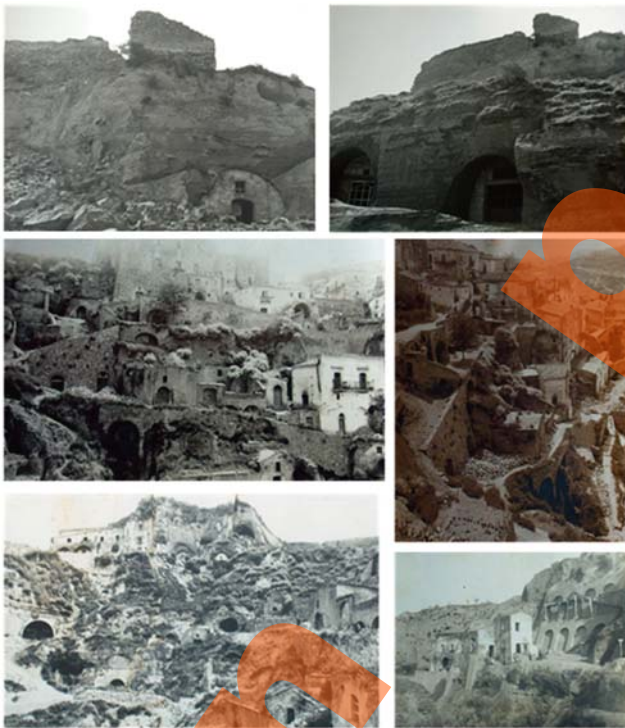
Fig. 4 - Documentazione fotografica storica della Rabatana : in alto due foto del 1973, in cui si può ancora notare parte del muro di cinta del castello, danneggiato dagli intensi eventi piovosi e successivamente abbattuto. Le sottostanti 4 foto risalgono invece al 1940 e mostrano la struttura insediativa terrazzata della Rabatana con le cavità poste a diverse altezze lungo i versanti che delimitano il borgo antico di Tursi.
