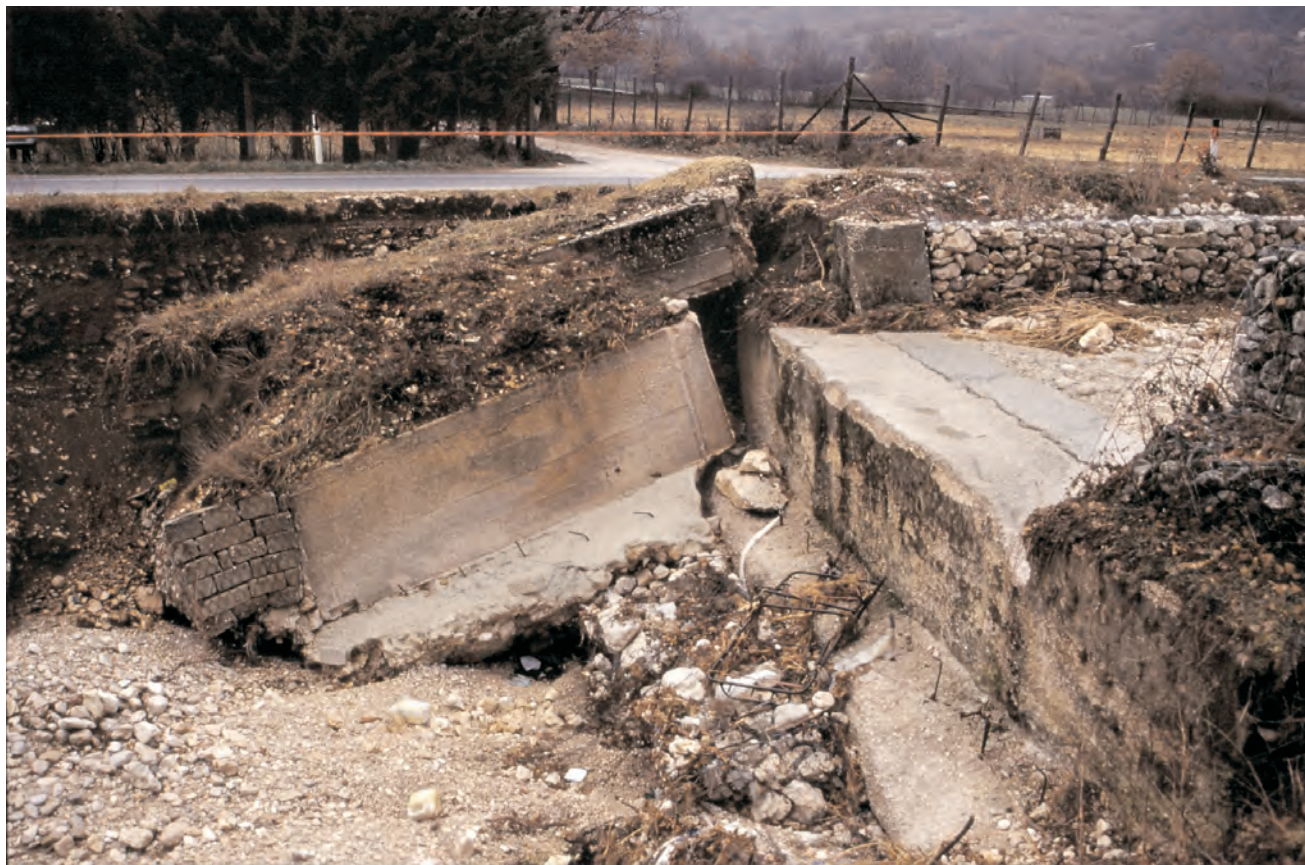
Fig. 82 - Opere di regimazione idraulica trasversali lungo l'alveo del Fosso Secco (Rocca di Botte), in gran parte distrutte dalla dinamica fluviale. - Transversal flow control structures along the Secco stream (Rocca di Botte), largely destroyed by fluvial dynamics.
