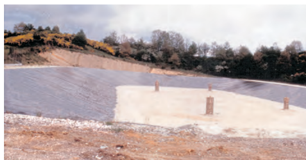
Fig. 81 - Discarica comunale di Carsoli (località Col Farolo) oramai non più attiva. Nell'immagine è possibile osservare l'impianto, adibito allo smaltimento di RSU, nella fase di realizzazione, ed in particolare i pozzi di captazione del biogas e la geomembrana in HPDE. La discarica è situata in parte sui limi, argille e sabbie del Bosco di Oricola (a destra) ed in parte sul substrato torbiditico (a sinistra) (da CHIARINI et alii , 2008).
