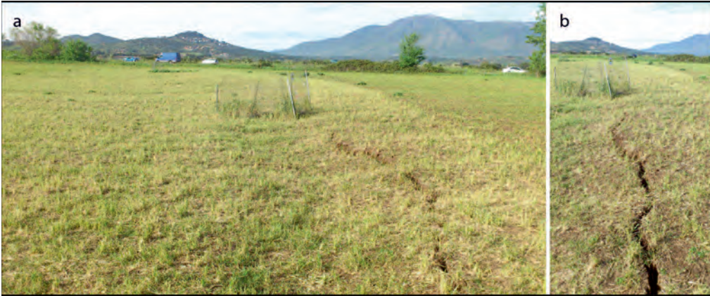
Fig. 5 – Vista da S. - a) In primo piano sprofondamento S2 e sullo sfondo sprofondamento S1. - b) Dettaglio della frattura prossima allo sprofondamento S2. - Photograph taken from S. - a) S1 collapse in the foreground, S2 collapse in the background. - b) Detail of the fracture next to S2 collapse.
