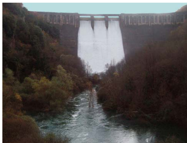
Fig. 2 - La Diga del Turano (fonte Wikipedia). - The Turano Dam (source Wikipedia).
