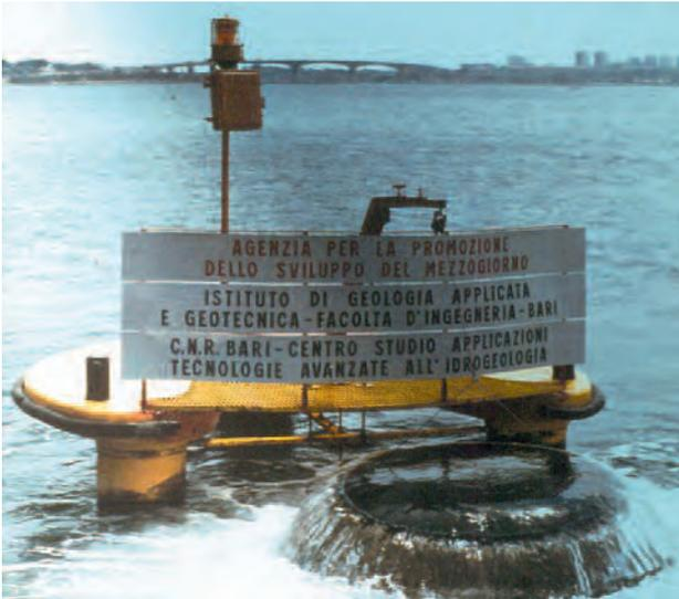
Fig. 17.51 - Foto dell'estremità superiore del condotto verticale che capta dal fondale marino l'acqua del Citro Galeoso trasferendola sulla superficie del mare.
