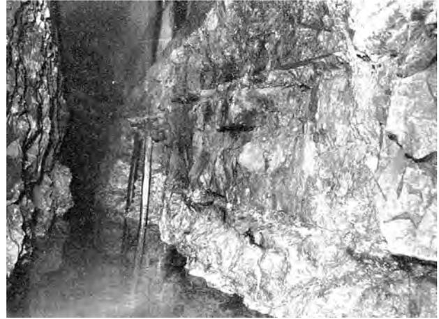
Fig. 12.23 – Pozzo orizzontale realizzato in prossimità di Mesagne (BR), dove l'acquifero carbonatico presenta una permeabilità dovuta essenzialmente ai giunti di strato.
