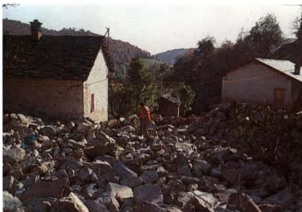
Fig. 5. – Val Sesia in provincia di Vercelli. Esempio di danneggiamento in area abitata per riattivazione di un conoide, alluvioni del 6-10 agosto 1978 (gentile concessione di V. Cocco, Regione Piemonte).
