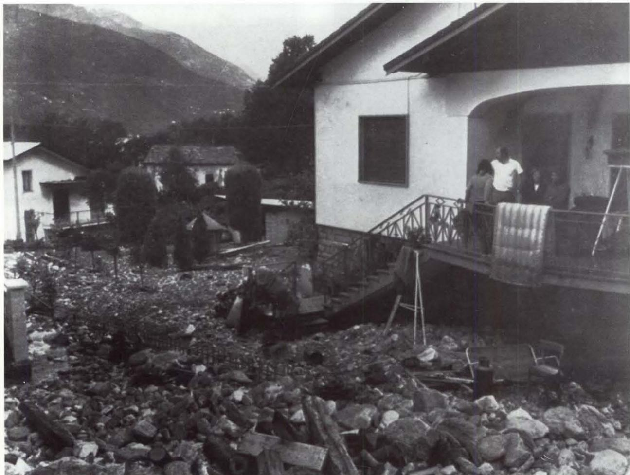
Fig. 6. – Domodossola, Val d'Ossola, provincia di Novara. Aspetto di un danneggiamento per trasporti in massa torrentizi ad opera di corsi d'acqua minori, alluvioni del 6-10 agosto 1978 (gentile concessione ANSA).
