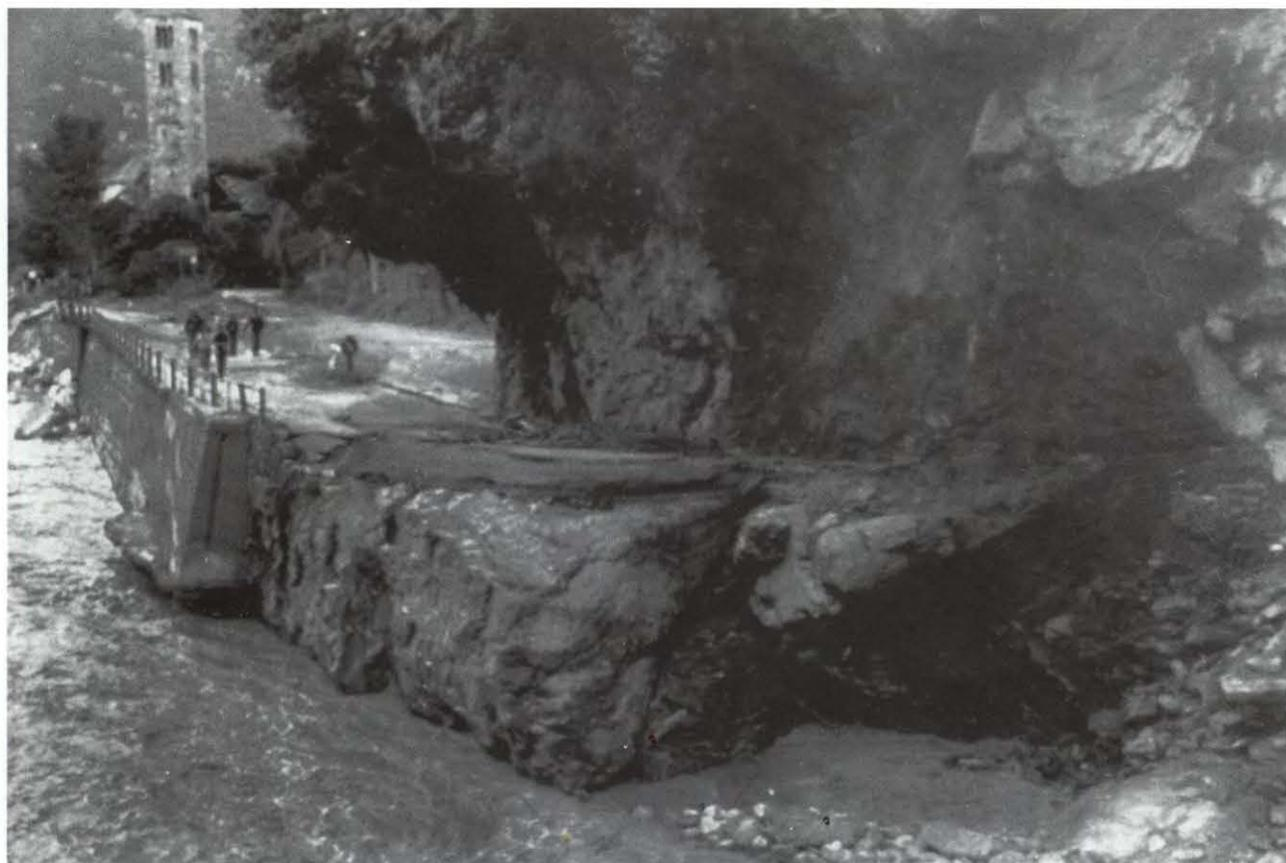
Fig. 7. – Masera in Val d'Ossola, presso la confluenza con il T. Melezze, provincia di Novara. Aspetto di un danneggiamento sulla SS. n. 337 per probabile scalmamento al piede ad opera delle acque torrentizie, alluvione del 6-10 agosto 1978 (*gentile concessione ANSA*).
