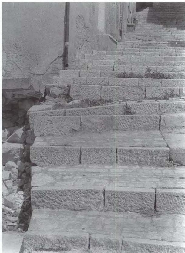
Fig. 65. – Casacalenda in provincia di Campobasso, 14 aprile 1987. Stesso problema della figura precedente. Il dissesto che interessa la scalinata ricade nel basso versante meridionale, presso la stazione ferroviaria (*fotografia dell'autore*).
