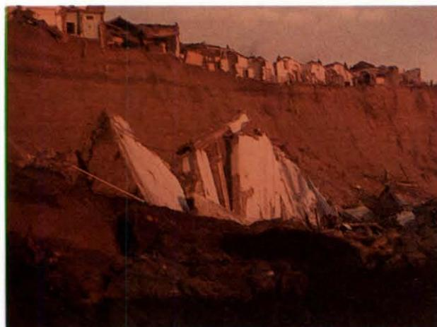
Fig. 92. – Abitato di Pisticci in provincia di Matera. Collasso del Rione Croci provocato da uno scorrimento rotazionale (con componente di colata verso valle), 21 novembre 1976 (fotografia di L. Merenda, CNR-IRPI Cosenza).
