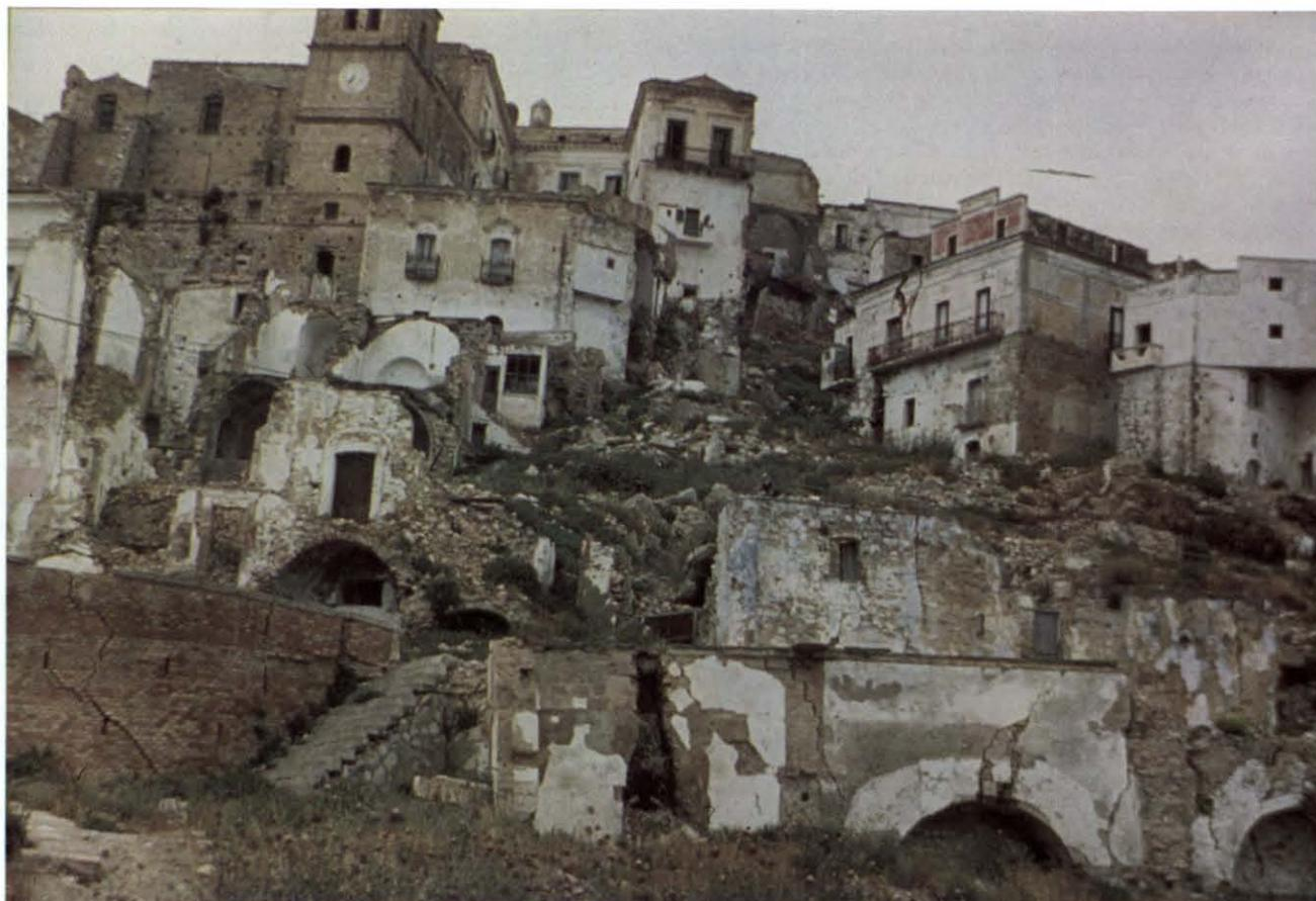
Fig. 89. – Craco in provincia di Matera, un comune quasi del tutto abbandonato per dissesti franosi (fotografia di L. Merenda, CNR-IRPI Cosenza).
