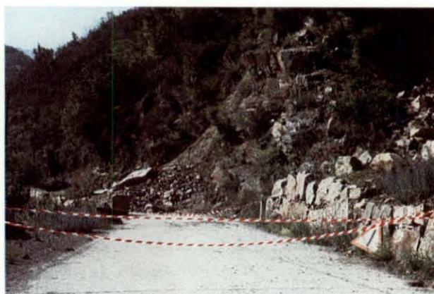
Fig. 1. – Val Chichero, comune di San Colombano in provincia di Genova. Franamento per crollo di rocce arenacee da un fronte di cava dismessa avvenuto nell'aprile 1986. La prolungata chiusura della strada spingerà molti residenti a restituire, per protesta, le schede elettorali alla prefettura (fotografia dell'autore).
