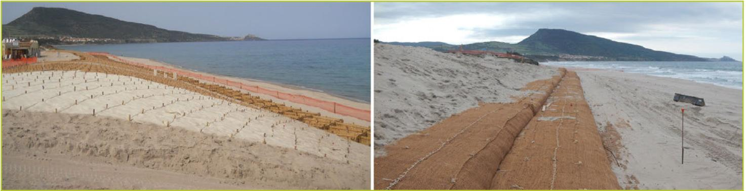
Figura 5. Spiaggia di San Pietro a Mare (Valledoria – SS) – Ripristino ambientale e ricostruzione del sistema dunare, in corso di realizzazione, a seguito della rimozione della strada litoranea attraverso l'utilizzo di georeti e stuoie in fibra naturale e consolidamento del nucleo con gecontenitori riempiti di sabbia (Fonte: Progetto "Interventi di ripristino ambientale di San Pietro a Mare nel comune di Valledoria").
