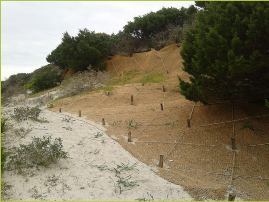
Figura 4. Spiaggia di Punta Molentis (Villasimius – CA) – georeti in fibra di cocco per la protezione della superficie delle dune a *Juniperus* spp. (Fonte: PROVIDUNE - LIFE07NAT/IT/000519 - “Conservazione e ripristino di habitat dunali nei siti delle province di Cagliari, Matera, Caserta”).
