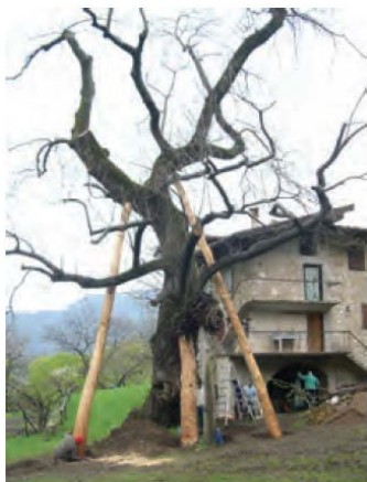
Fase di consolidamento del Maroner di Carobbi (A. Ricci)
