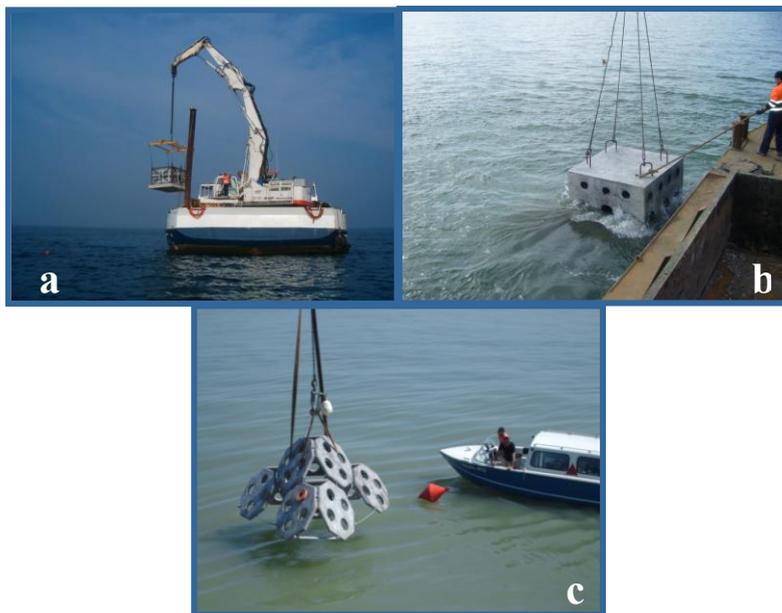
Figura 2.9 Varo del primo campo barriere realizzato nell'ambito del Progetto per la gestione dell'allestimento di barriere artificiali sommerse (L.R. n. 15/2007): a-b) strutture perimetrali c) strutture Technoreef.
