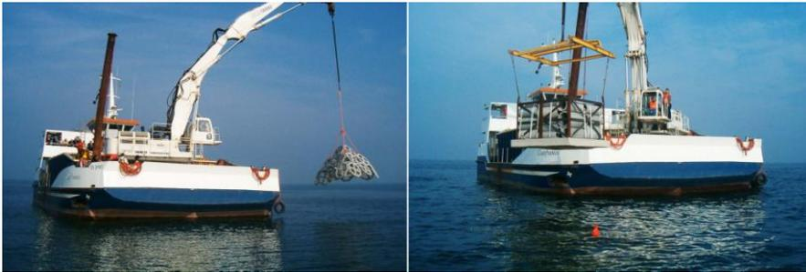
Figura 2.5 Posa delle barriere artificiali.
