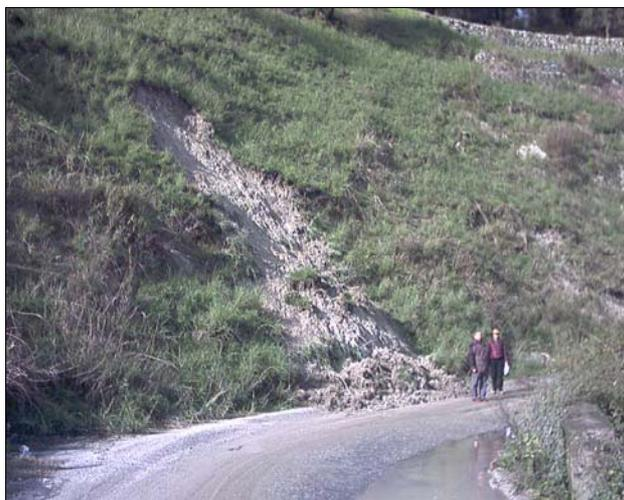
Figura 23.28 S.P. Palmi San Procopio (Ponte Mangano). Scorrimento-colata in materiali di copertura a granulometria fine, con invasione della sede stradale.
