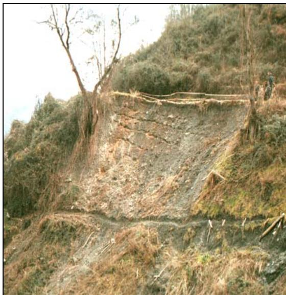
*Figura 23.18 Martirano Lombardo (CZ): esempio di frana per scorrimento superficiale nelle metamorfiti di basso grado (in particolare nella coltre argillificata di alterazione superficiale) che ha interessato una strada comunale.*
