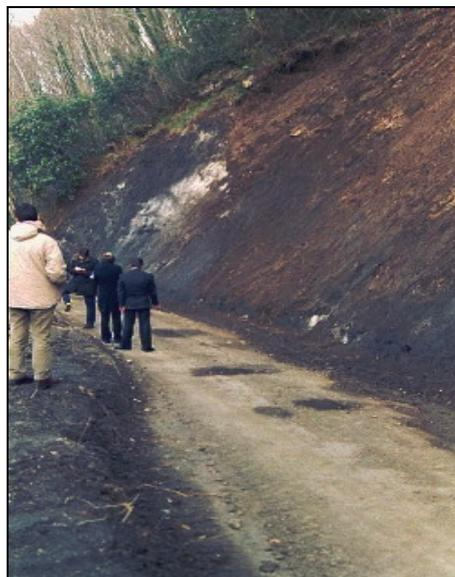
*Figura 23.19 Martirano (CZ): esempio di frana per scorrimento superficiale nelle coperture di alterazione delle metamorfiti di basso grado, con danni alla viabilità e crollo di opere di sostegno.*
