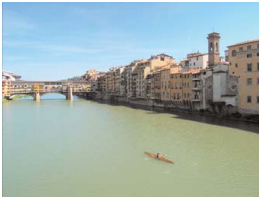
Figura 4 Ponte Vecchio sull'Arno (Foto Mamone - 2005)
