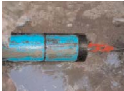
Fig. 26: Dettaglio dell'intervento di slip-lining
