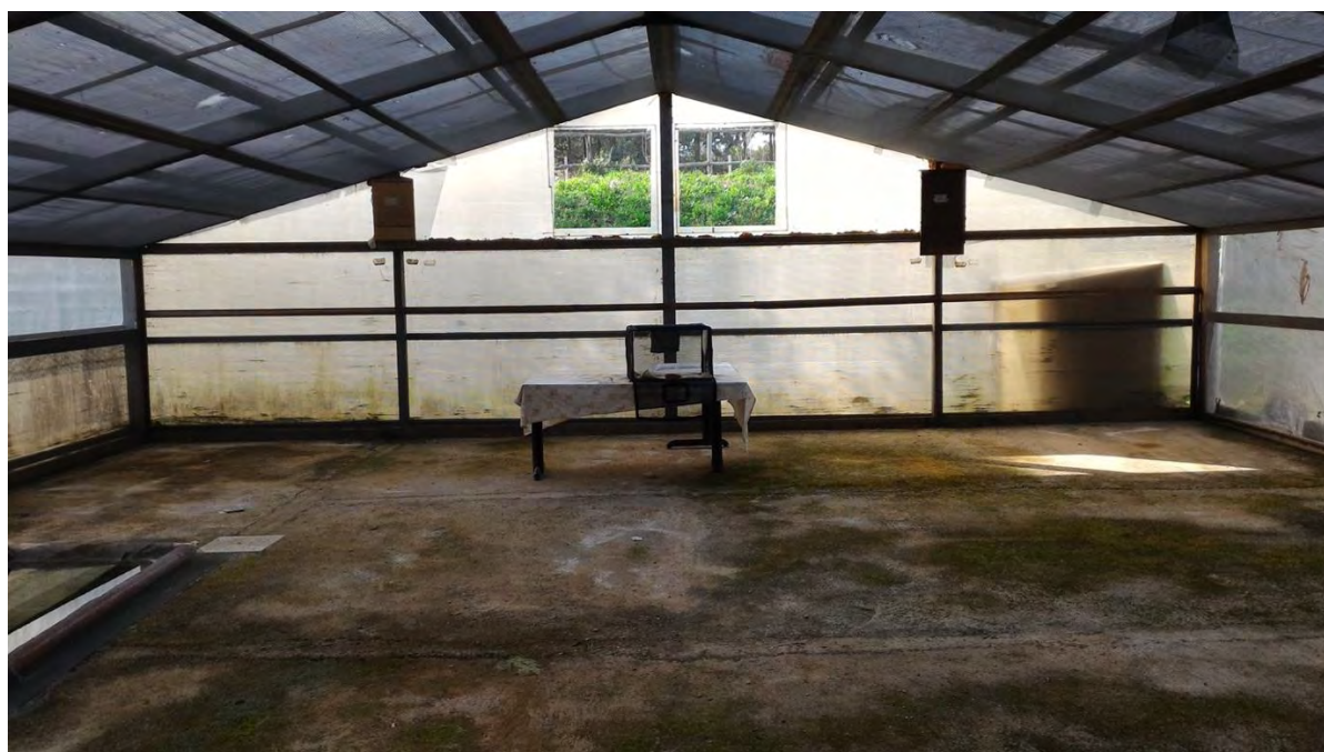
Fig. 8.6 Esempio di voliera esterna con struttura esterna in lastre di policarbonato, rete metallica come intramezzo e internamente con rete tipo zanzariera per il volo dei Chiroterri (foto A. Tomassini).
