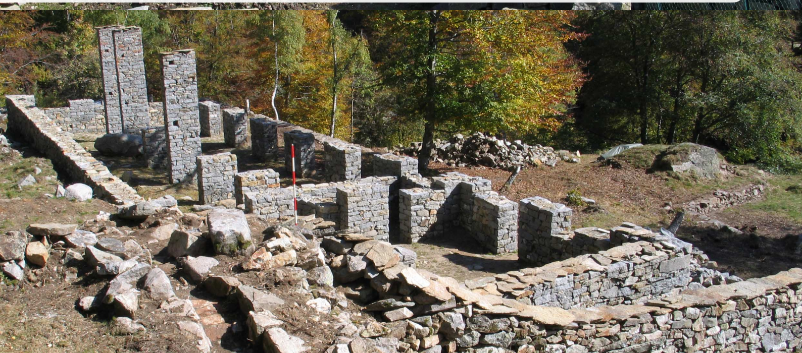
Opificio in riva destra Sessera: frantoio idromeccanico, laveria e forno di assaggio per l'arricchimento dei solfuri misti di Costa l'Argentera (1756-1780) - Foto: Maurizio Rossi
