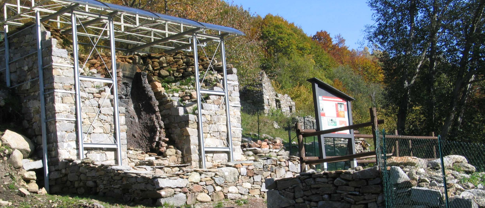
Rondolere (1788-1804): alto forno “alla bergamasca”, trasformato “alla contese” in età napoleonica, collegato alle miniere di magnetite di Pietra Bianca - Foto: Maurizio Rossi
