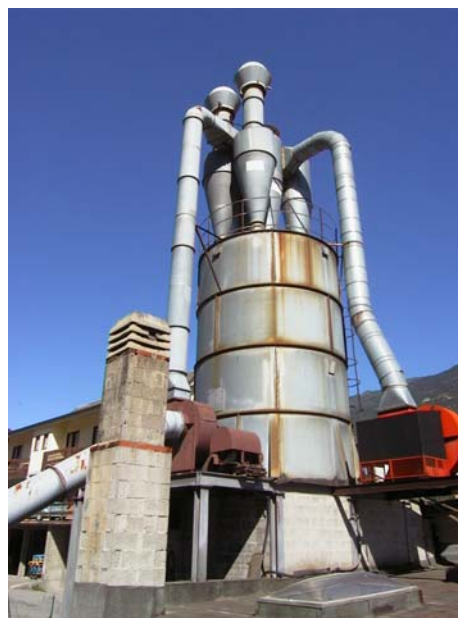
Figura 9: Silos esterno di raccolta dei trucioli e delle polveri di legno con sistema di abbattimento a ciclone
