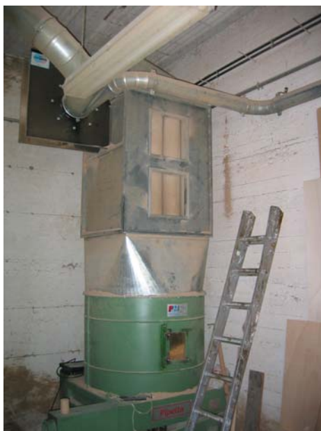
Figura 8: Filtro a maniche racchiuse con sottostante bricchettatrice
