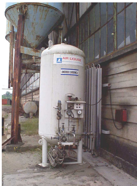
Foto 2.1.9 Serbatoio esterno dell'anidride carbonica.
