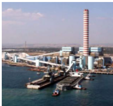
Fig. 6 nave carboniera mentre attracca alla banchina della centrale
