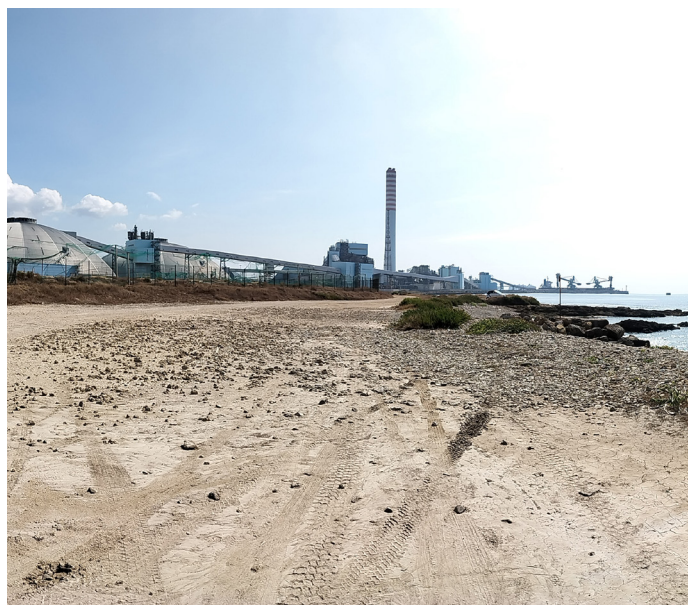
Fig. 2 - La centrale elettrica di Torrevaldaliga
