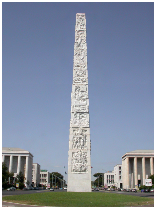
Fig. I-9 - EUR, la stele di Marconi, in cemento armato e rivestimento in marmo di Carrara come i palazzi nello sfondo.
