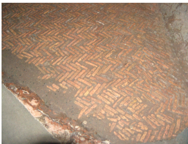
Fig. G-7 - Basilica di S. Clemente, spinato in mattoni del pavimento romano. - Basilica of S. Clemente, herringbone brick structure of the Roman floor.
