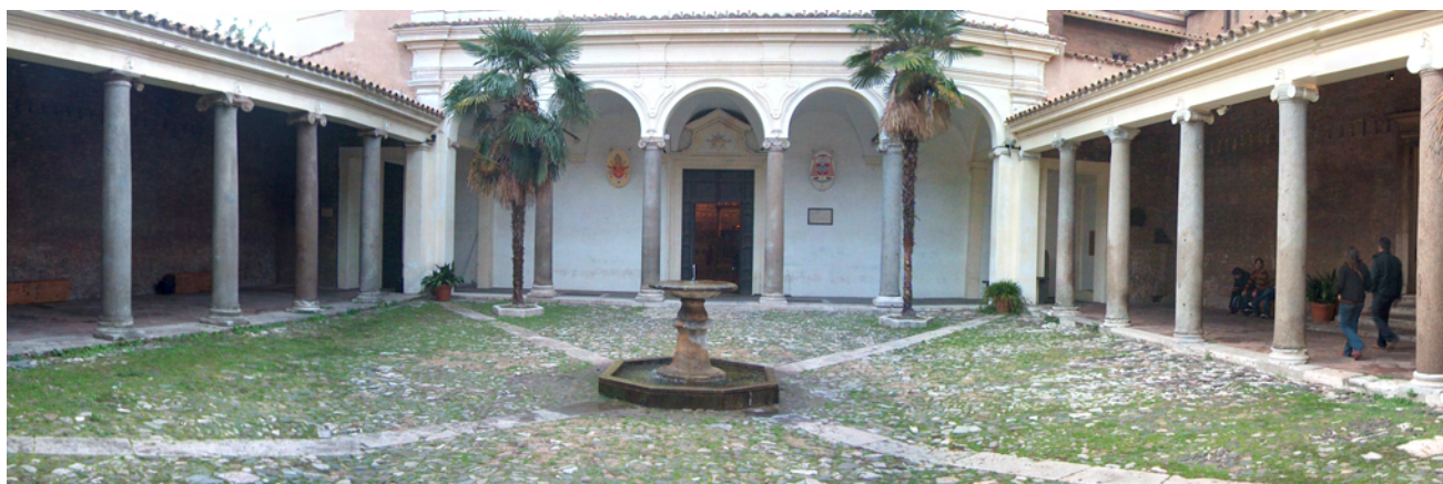
Fig. 6-3 - Basilica di San Clemente, portico del XII sec.; reimpiego di colonne di vari marmi antichi. - The 12th century portico of the Basilica of S. Clemente; re-use of different ancient marble columns.
