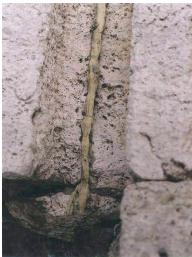
Fig. 8-3 - Depositi di zolfo e gesso in scanalature nella muratura in travertino di Ponte Sisto. - Sulphur and gypsum deposits in fissures between travertine blocks of Ponte Sisto.
