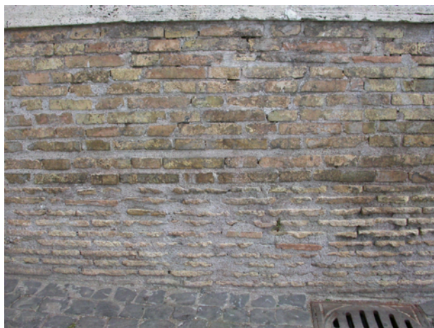
Fig. G-1 - Ponte Milvio, parapetto con sovrapposizione di laterizi di spessore ed epoche diverse.
