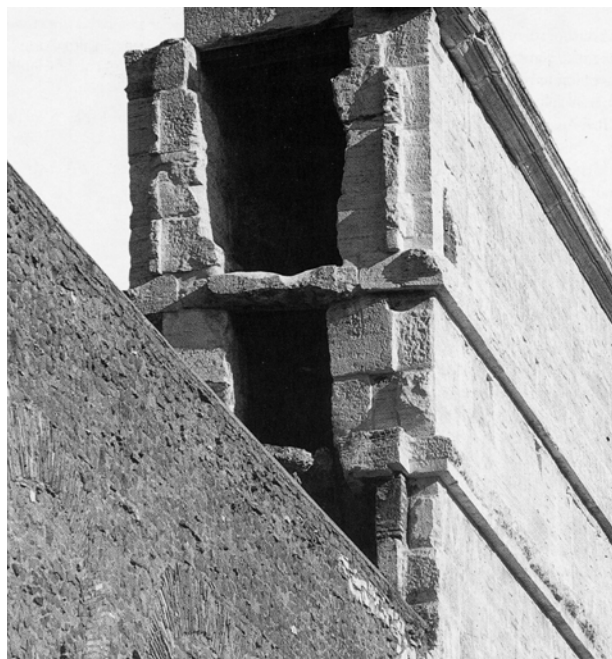
Fig. 18 - Porta Maggiore: gli specchi della Claudia e dell'Anio Vetus sovrapposti. - Porta Maggiore the two overlapping specus channels of the Aqua Claudia and the Anio Novus.
