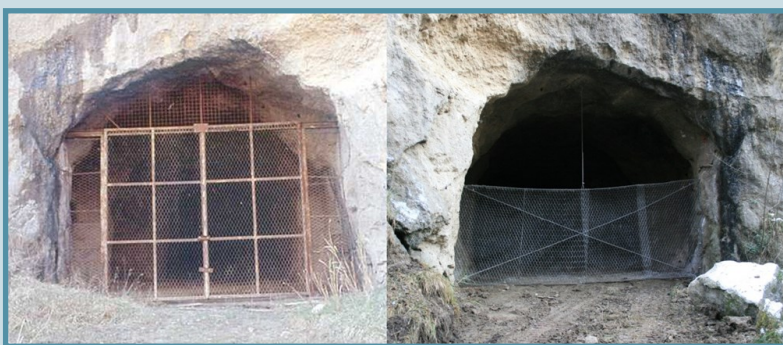
Figura 2. Uno dei cancelli della ex cava SPES prima (2004) e dopo gli interventi (2013), con la porzione superiore libera da recinzioni (foto di M. Bertozzi).
