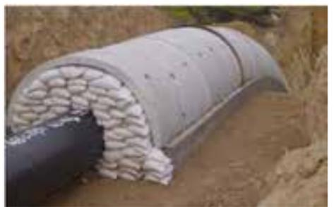
**Involucro di protezione della condotta di gas naturale ad alta pressione Megara - Corinto, finalizzato ad assorbire l'eventuale dislocazione cosismica.**
