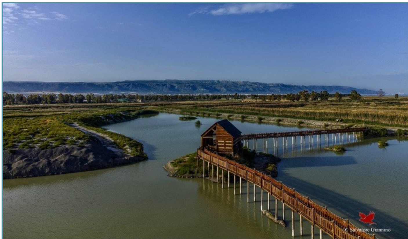
Figura 2. Vista panoramica del capanno e della passerella sulla laguna (foto di S. Giannino).
