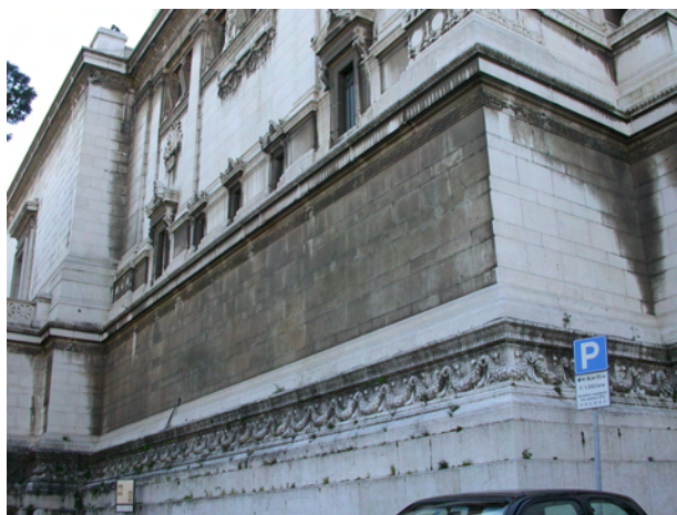
Fig. N-3 - Vittoriano, su blocchi di marmo botticino, croste nere da alterazione superficiale per attacco di atmosferici. - Vittoriano, black crusts from atmospheric alteration on botticino marble blocks.
