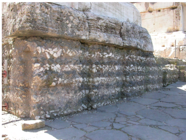
Fig. F-4 - Basamento dell'Arco di Tito, con massicci blocchi di travertino sovrapposti a fondamenta in opus caementicium . - The foundation of the Arco di Tito, with massive travertine blocks overlapping an "opus caementicium" basis.
